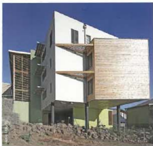
Les protections solaires sont adaptées à l'orientation : brise-soleil horizontal, verticaux, jalousies, claustras...
